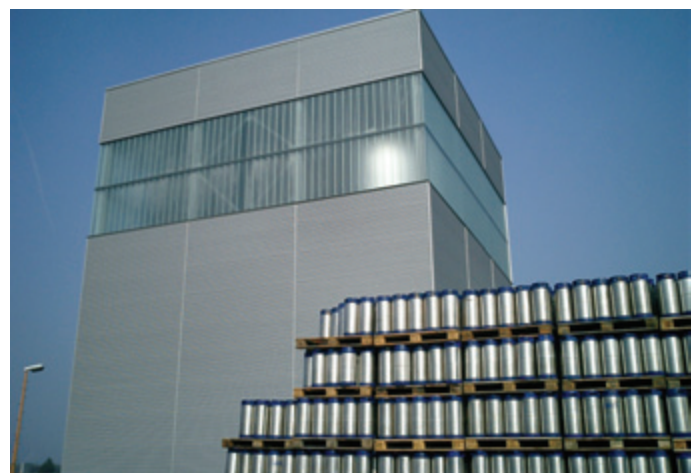
Abb. 5 Neues Tankgebäude der Tucherbräu, Fürth mit Pipeline-Übergabestation
