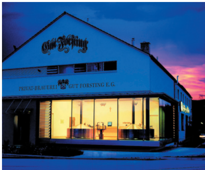
Abb. 2 Nachtansicht des Sudhauses der Brauerei Gut Forsting
